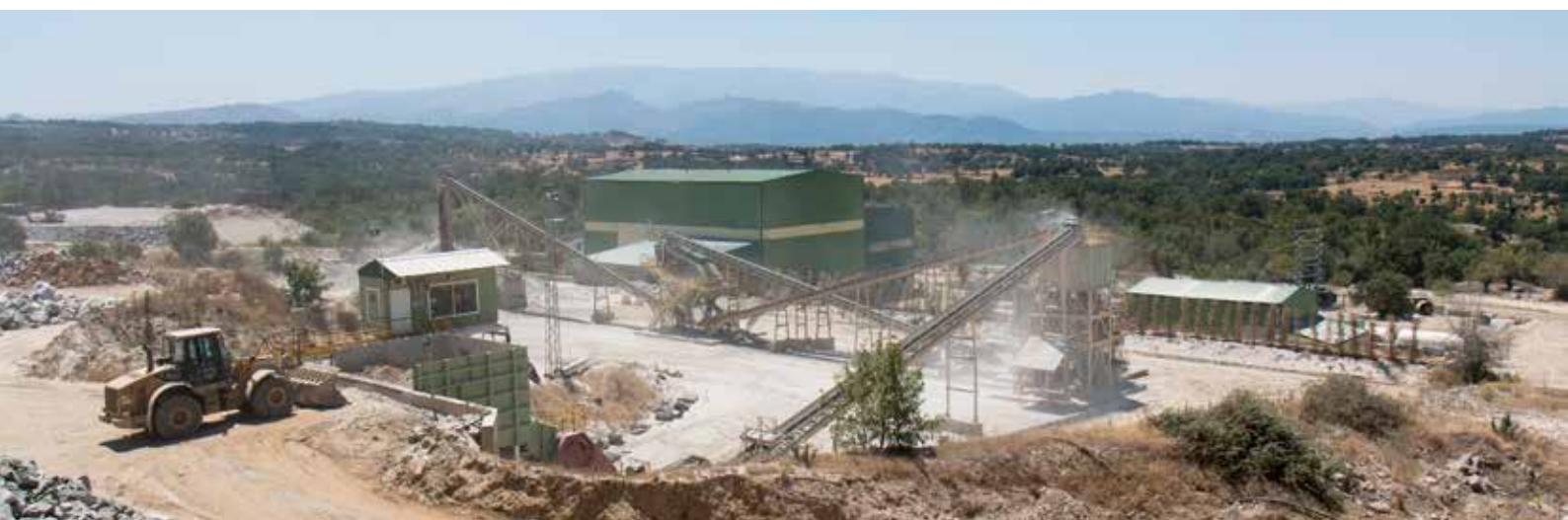
BRECHER UND AUFBEREITUNGSANLAGE VON ALMONTY IN LOS SANTOS, SPANIEN
