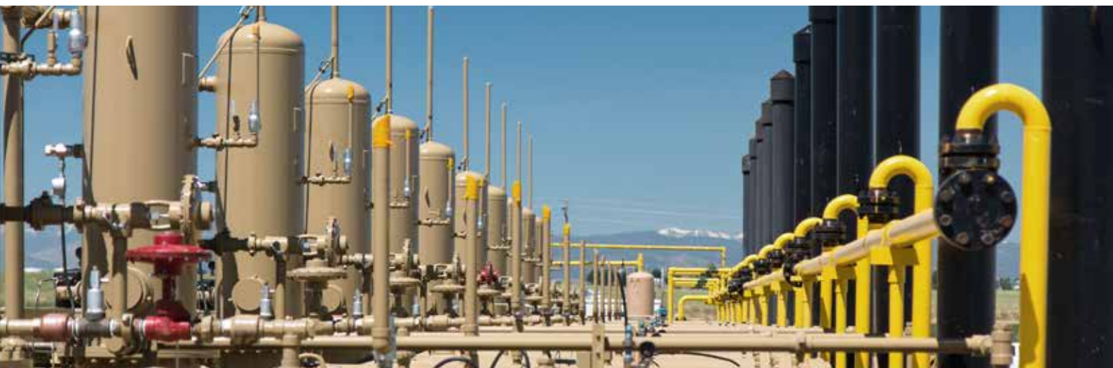
NEU ERRICHTETE SEPARATOREN AUF DEM WIND PAD, USA
